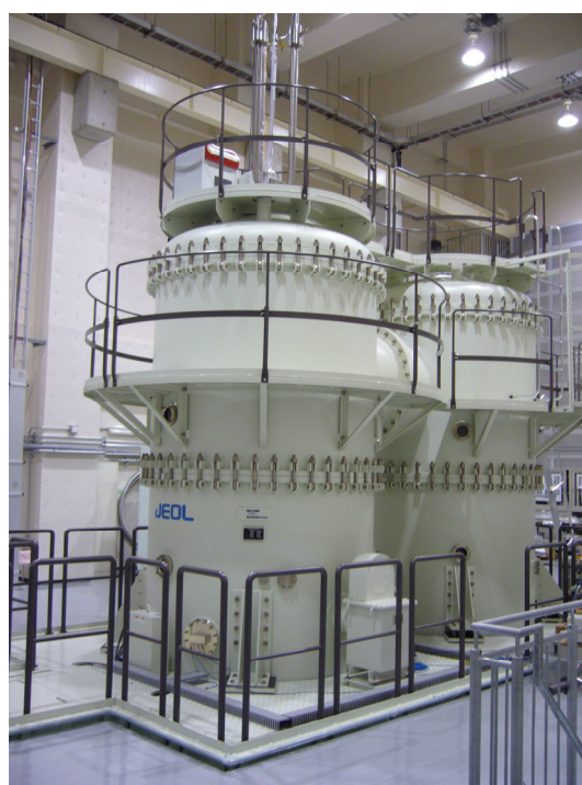
図 3 反応科学超高压走査透過電子顕微鏡 2 階の高電圧タンク部
